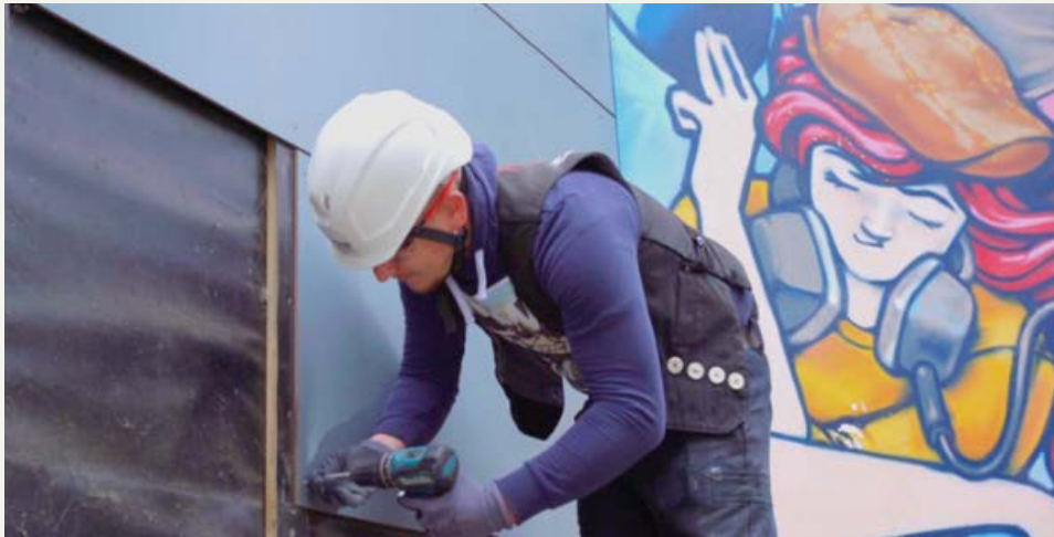
Eenvoudige demontage van panelen van Rockpanel
