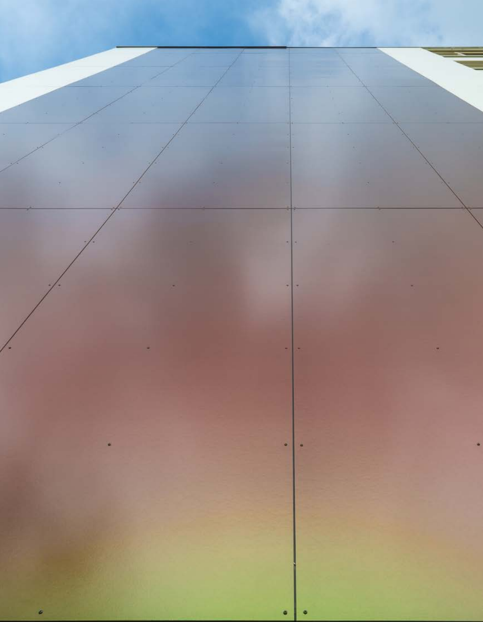
Projet de rénovation d'un immeuble d'appartements, Haarlem, Pays-Bas
